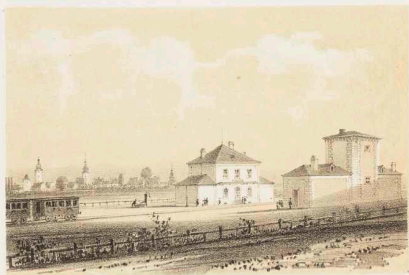
STATION LITTAU, LITTAU IM HINTERGRUND.
