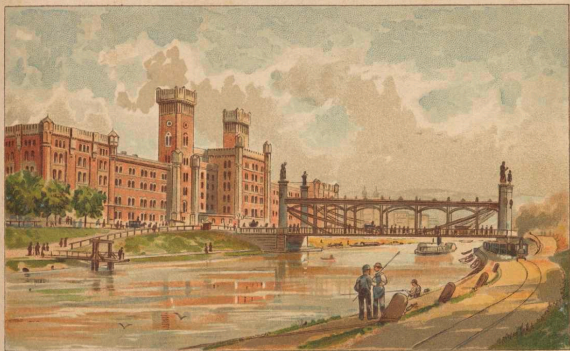
29 Augartenbrücke und Rudolfskaserne.
