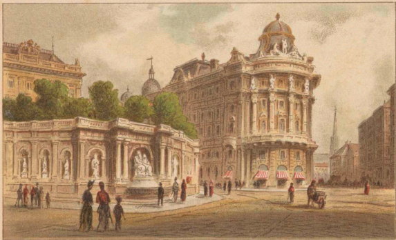
6 Palais Albrecht (Rampe) und Philip-Hof.
