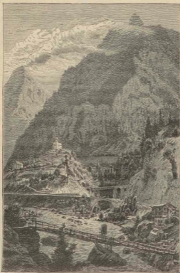
Fig. 51. — Chemin de fer du Saint-Gothard. — La Maienreuss à Wasen.
