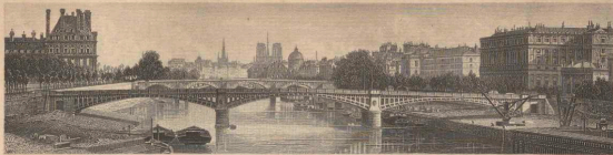
AUSSICHT VOM PONT DE LA CONCORDE.
