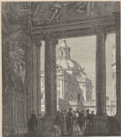
VOUE LE PORTIQUE DE SAINT-PIERRE (CÔTÉ DE LA SACRISTIE)
