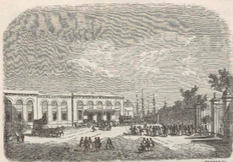
Dédouaneement du Havre.
