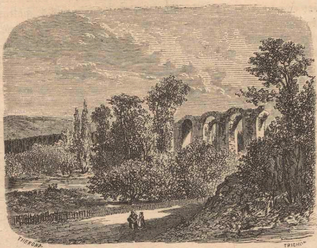
Aqueduc de Maintenon.
