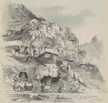
Abbaubild von der Schiller-Etage nächst der Gloriette mit angefahrenen alten Zechen und Schrägstollen.
