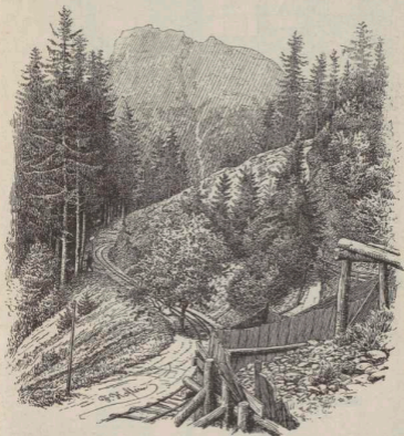
Abstieg durch die neuen Anlagen vom Vordernberger Berghause auf die Ebenhöhe (Christoph-Etage, 1186 Meter ü. d. M.).
