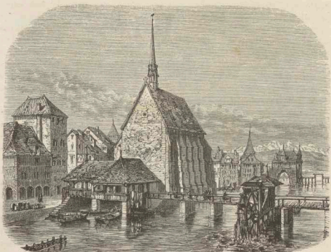
La Wasserkirche , avant la transformation de cette église en bibliothèque municipale.
